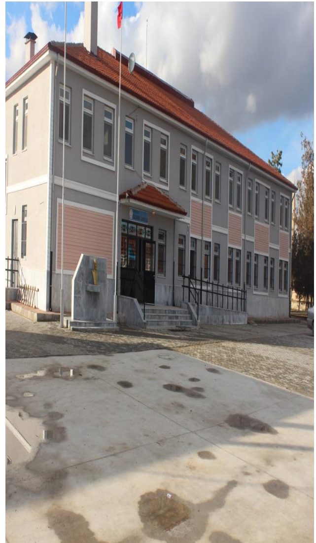
Merkez Sülümenli İlkokulu 12 Derslik Yapımı
